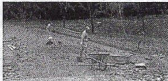
L'arena per le gare è in fase di costruzione a Vermogno
